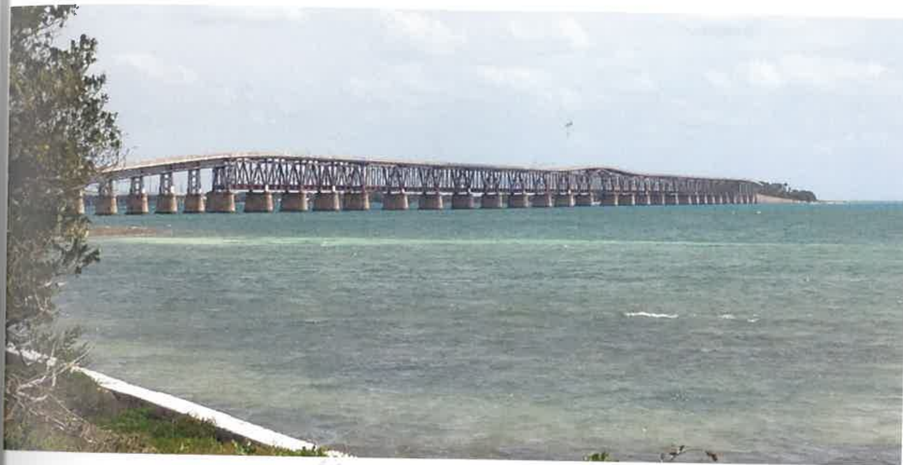
Původní železniční most mezi ostrovy cestou z Key West
